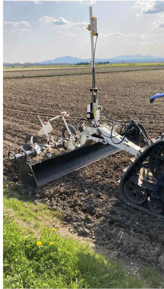
図5. レーザレベラによる均平作業
